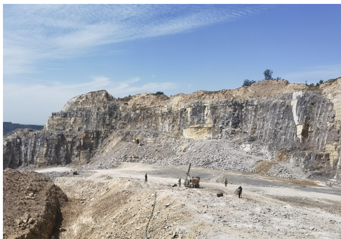
照片 8-1 XP1 不稳定边坡(镜向北西)
