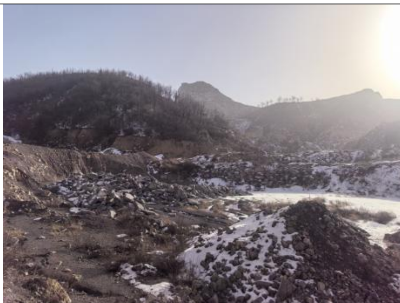
照片 2-1-5 拟建 1 号排土场所在沟谷
