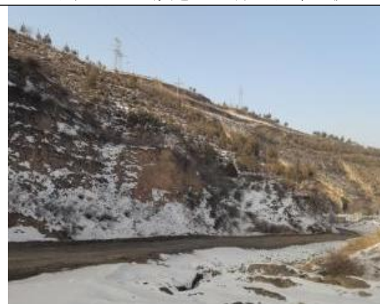
照片 2-1-4 拟建工业场地南部道路边坡
