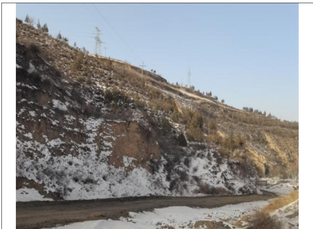
照片 8-3-1 矿山道路南侧边坡
