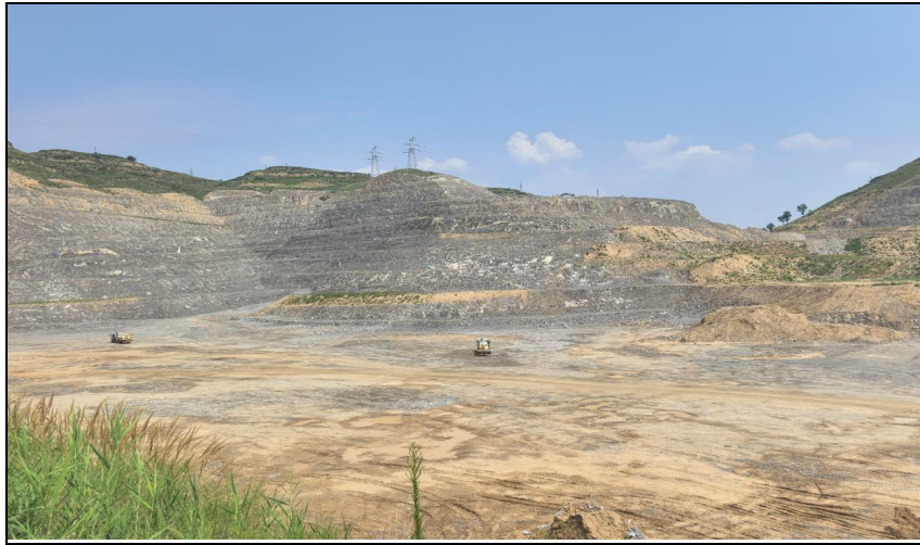
照片 8-2-1 露天采场北部边坡照片
