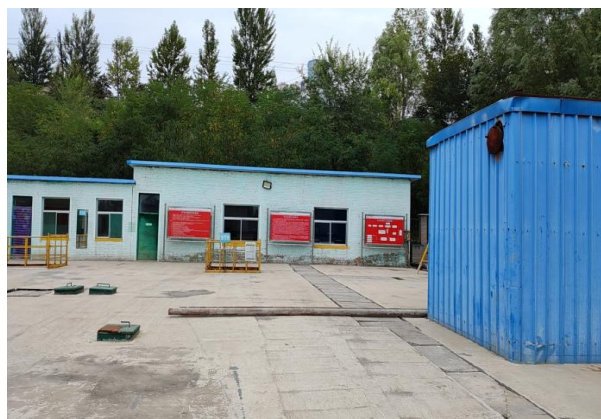
照片 8-2-10 生活污水处理站外观
