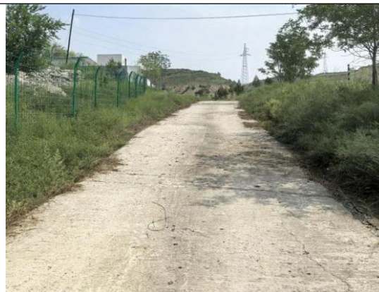
照片 8-2-15 矿区道路照片
